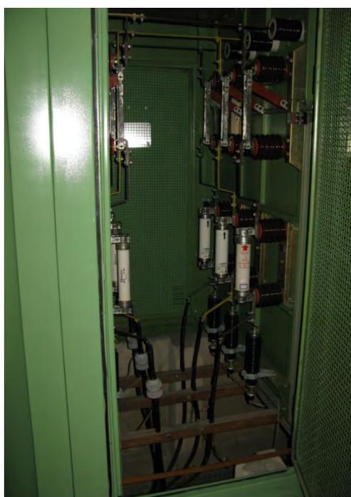
Figura 5.3 - Cubículos das seccionadoras da subestação antiga
