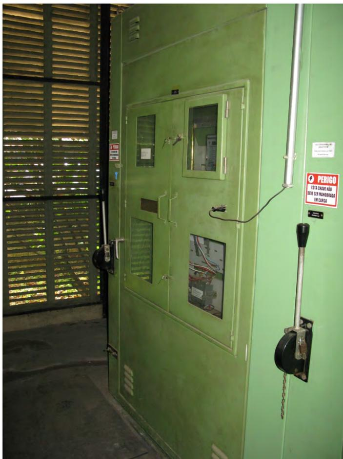
Figura 5.1 - Cubículo de entrada de energia da subestação antiga
