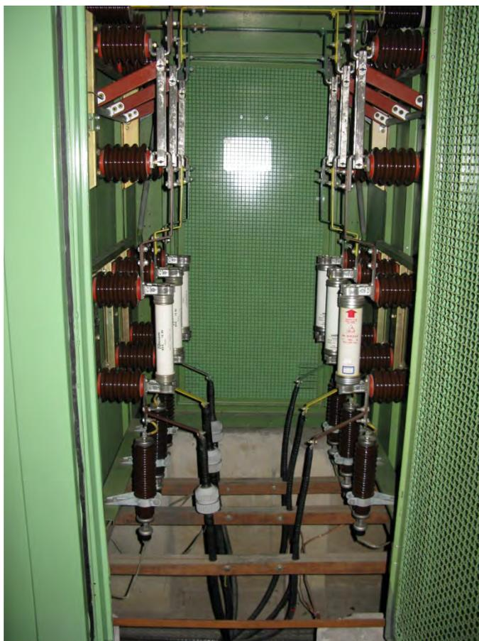
Figura 5.5 - Cubículo das seccionadoras da subestação antiga
