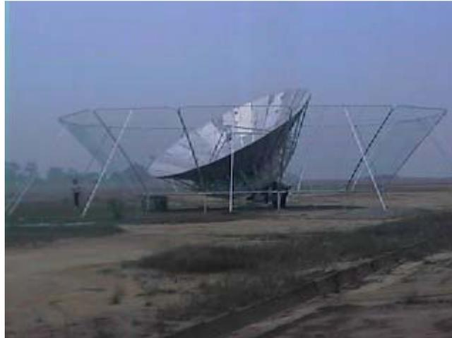
Fig. 3.3 – O radiotelescópio GEM com a cerca e painéis de extensão na sede do INPE em Cachoeira Paulista – SP – Brasil ( Lat.  $-22,68^\circ$ ; Long.  $45,00^\circ$  ).
