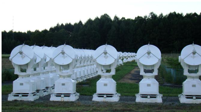
Figura A.2 - NoRH: no primeiro plano antenas do braço leste-oeste, com extensão de 490 m, e ao fundo o braço norte sul, com extensão de 220 m.
